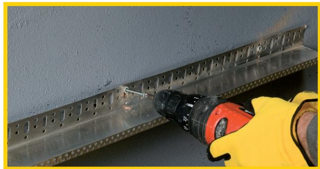
Montare i profili in alluminio perfettamente in orizzontale mediante tasselli posizionati ogni 30 – 50 cm.
