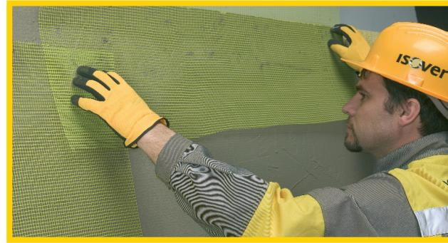
Applicare la prima mano di rasante annegando una rete portaintonaco in fibra di vetro alcaliresistente con sovrapposizione tra le strisce di almeno 10 cm.
