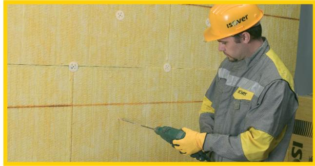
Oltre al fissaggio tramite colla, i pannelli **CAPP8** devono essere fissati attraverso l'uso di tasselli.
