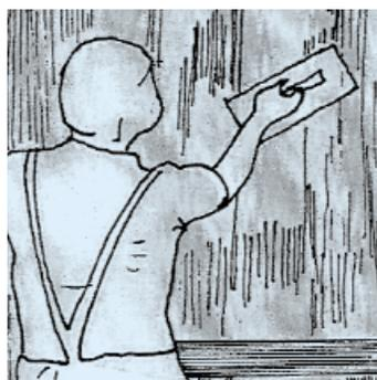
In corrispondenza degli spigoli la rete non deve essere tagliata ma si deve prevedere un risvolto con una sovrapposizione di almeno 10 cm. (solo utilizzando l'armatura rinforzata semirigida è consentita la posa a "spigolo vivo" dell'armatura).
