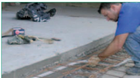
sue caratteristiche. Usato per impermeabilizzare le riprese di getto tra platea e pareti, costituisce insieme al **Bentofix® BFG5000** un ottimo sistema impermeabilizzante in grado di risolvere le notevoli problematiche legate alla presenza d'acqua nei cantieri.
